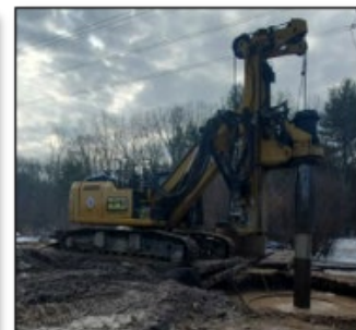
Plataforma de perfuração
