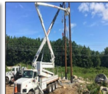
Camião grua com cesta
